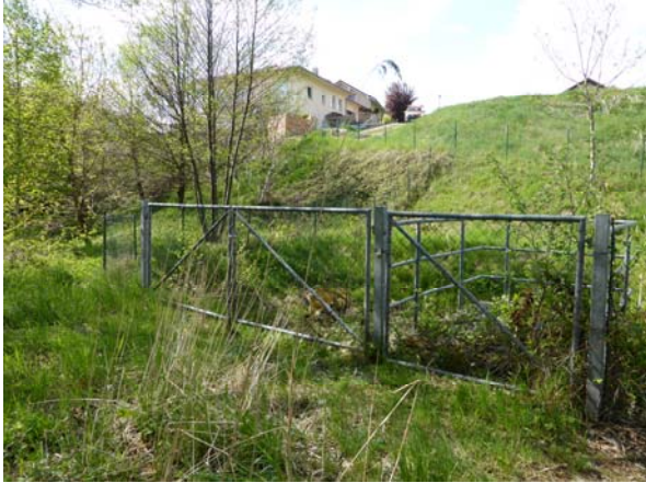
Foto 1: Ansicht RRB Umzäunung
