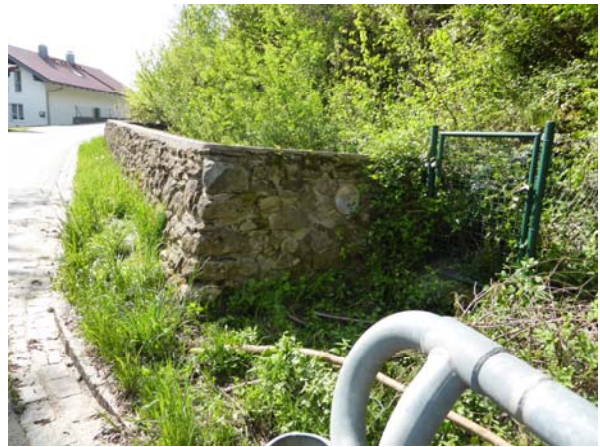
Foto 2: Stahlbetonwand, mit Granitsteinen verkleidet
