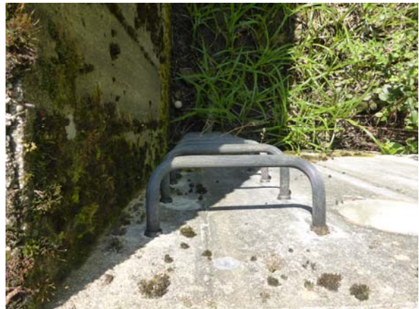
Foto 4: Notüberlauf, Ablauf Drosselöffnung DN 50
