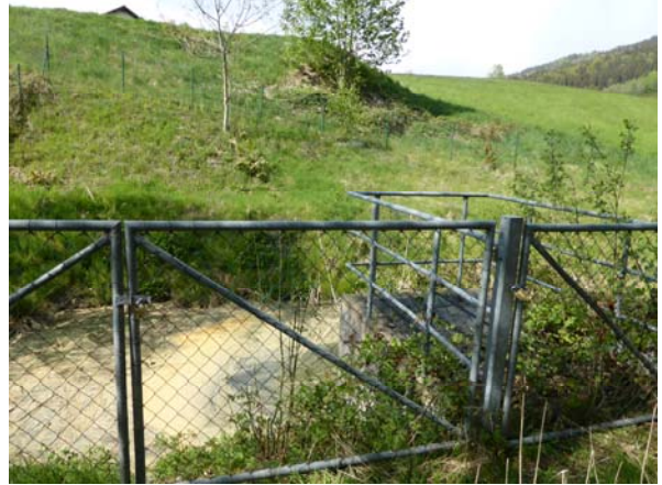
Foto 2: Ansicht RRB Umzäunung
