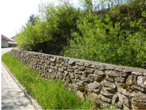
Foto 1: Stahlbetonwand, mit Granitsteinen verkleidet
