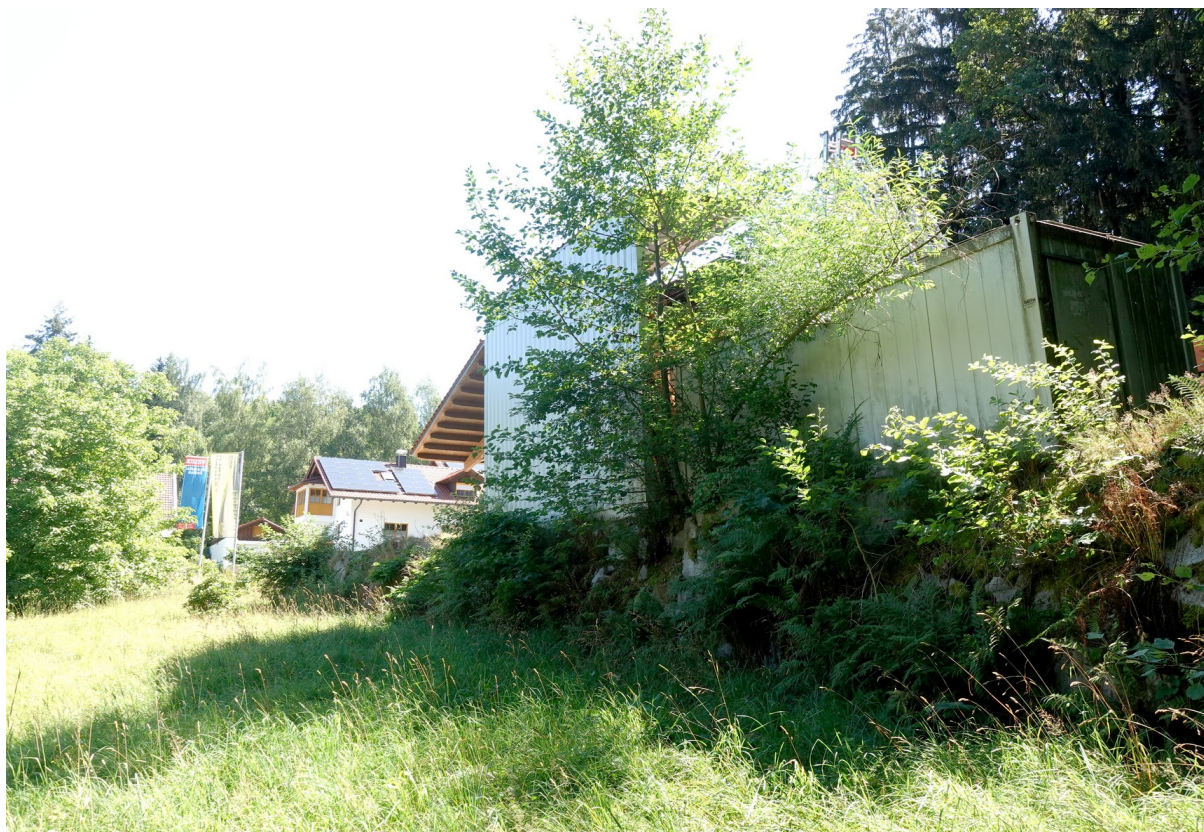
Abbildung 3: Stützmauer am Nordwest-Eck der Auffüllungsfläche, Ausführung als Trockensteinmauer mit Spontanbegrünung.
