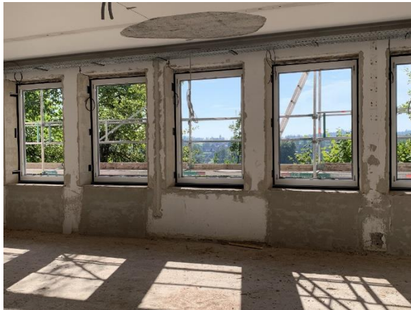
Anbringen der Fenster
