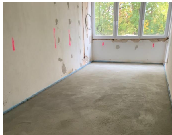
Verlegung Estrich KG
