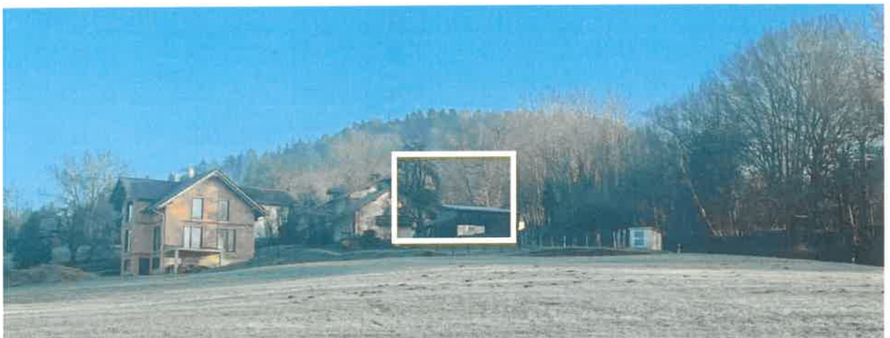
Foto1: Blick von Südwesten auf den Baustandort (weiße Linie zeigt etwa den geplanten Standort des Gebäudes) Foto: Bieber 19.01.2025
