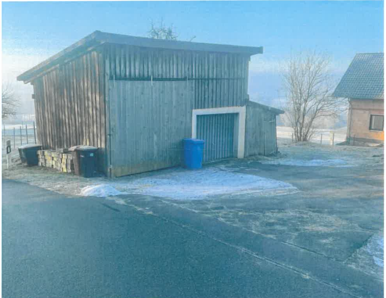
Foto2: Blick von Nordosten auf das abzureißende Nebengebäude
